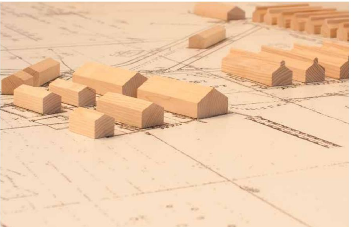
■ De maquette op de tentoonstelling toont de barakken van weleer. Eind 1947 werd het kamp gesloten en werden de houten barakken ontmanteld. In de stenen gebouwen werden tijdelijke noodwoningen opgericht. Foto: Paul De Schepper
