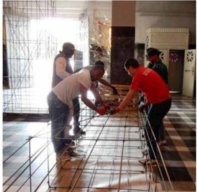
■ Vrijwilligers uit de buurt werkten mee aan de constructie van de betonijzeren installatie. © Poli Roumeliotis
